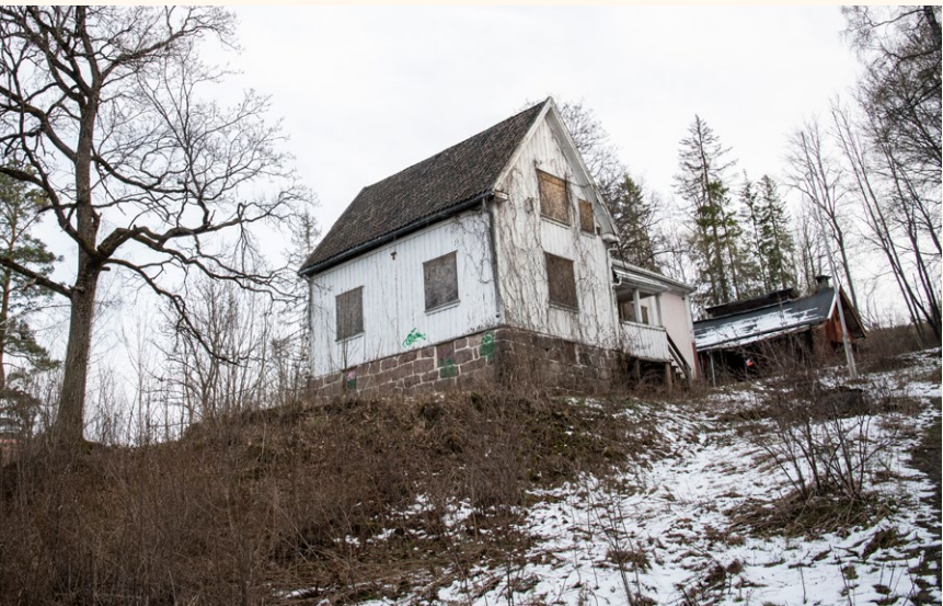
GJENBRUK: Flere bygninger i Atelierhagen skal bevares i fremtiden og brukes til felles formål.
