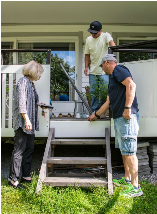
SJEKKET STANDARD: I fjor ble samtlige balkonger i boligsameiet i Sandvika rehabilitert. Da det skulle gjennomføres en befaring ett år etter, var styreleder Helle Vikdal, ABBLs representant Stian Krag Iversen og anleggsleder Roy Arnesen til stede. (Foto: Katrine Lunke)
