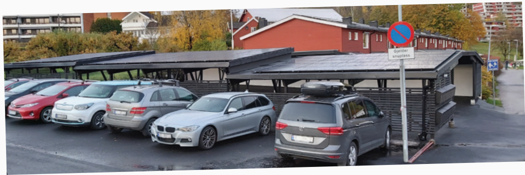
Solceller på garasjeanlegget på Haugergrenda. Foto: Svein Medhus
